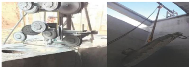
Figura 11 – Equipamento de corte e remoção de laje
